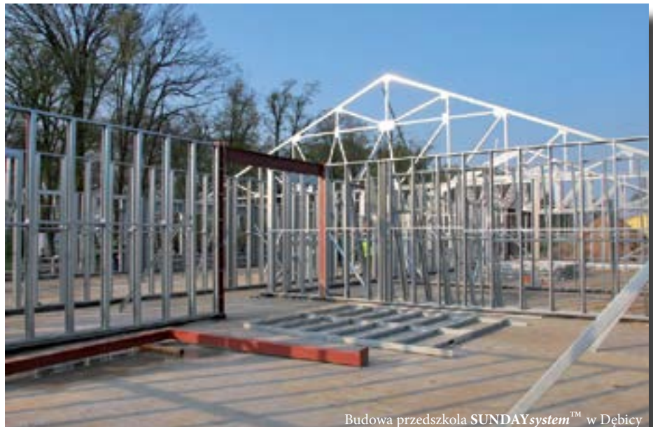
Budowa przedszkola SUNDAYsystem™ w Dębicy
