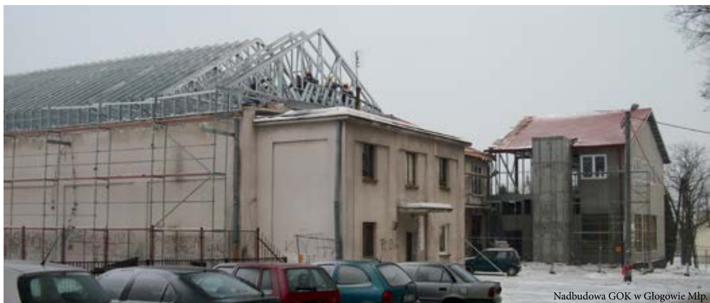
Nadbudowa Gimnazjum w Sędziszowie
