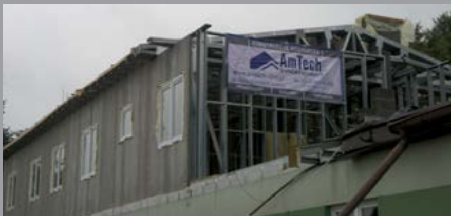
3 - Montaż dźwigarów dachowych
