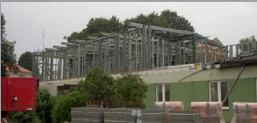
1 - Montaż zewnętrznych paneli ściennych
