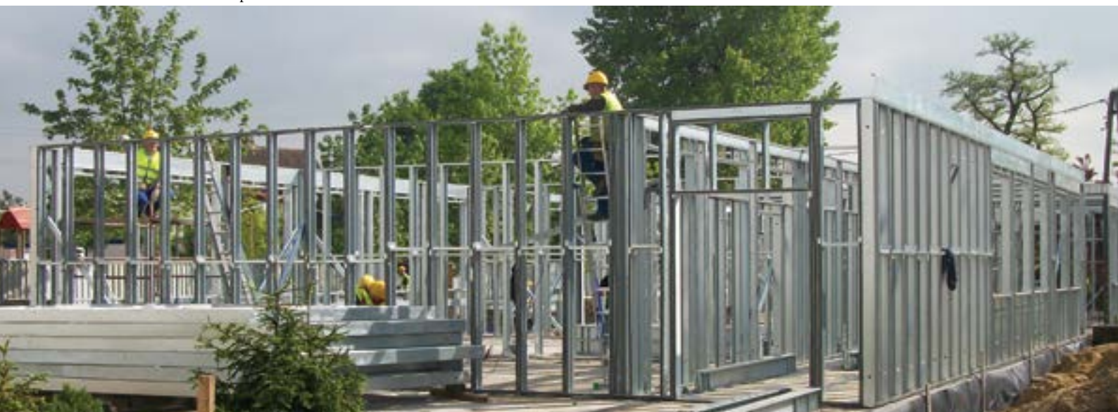
Przedszkole w Siechnicach - prace budowlane
