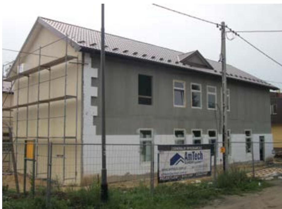
Izolacja zewnętrzna
