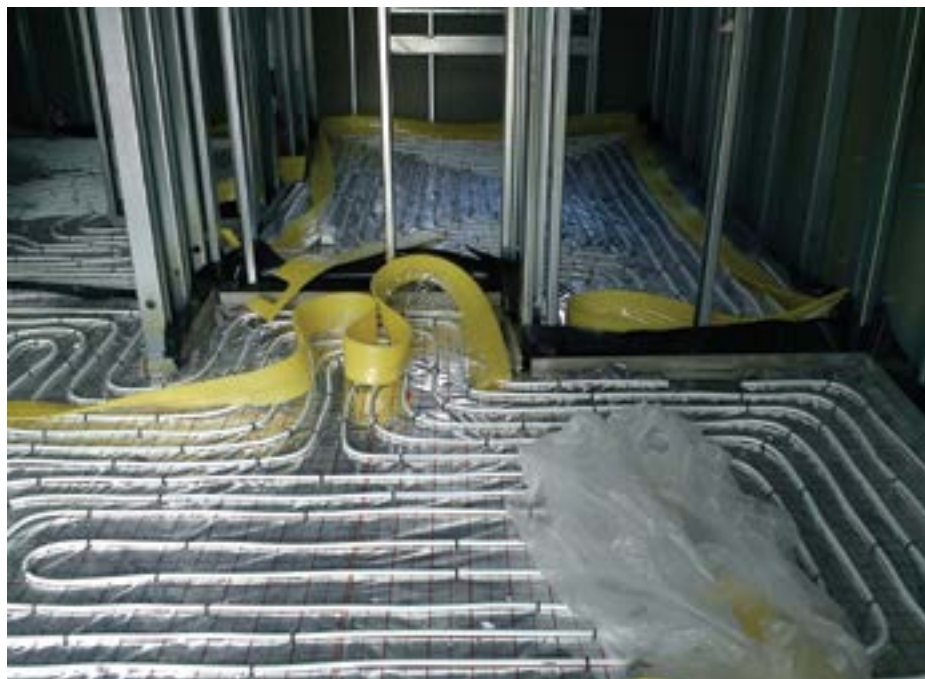
Ogrzewanie podłogowe
