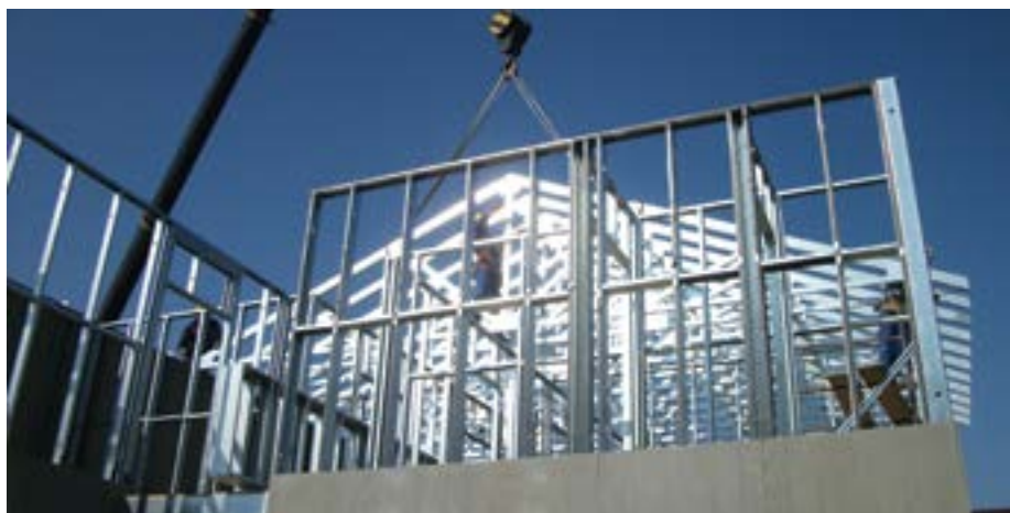
Montaż dźwigarów dachowych
