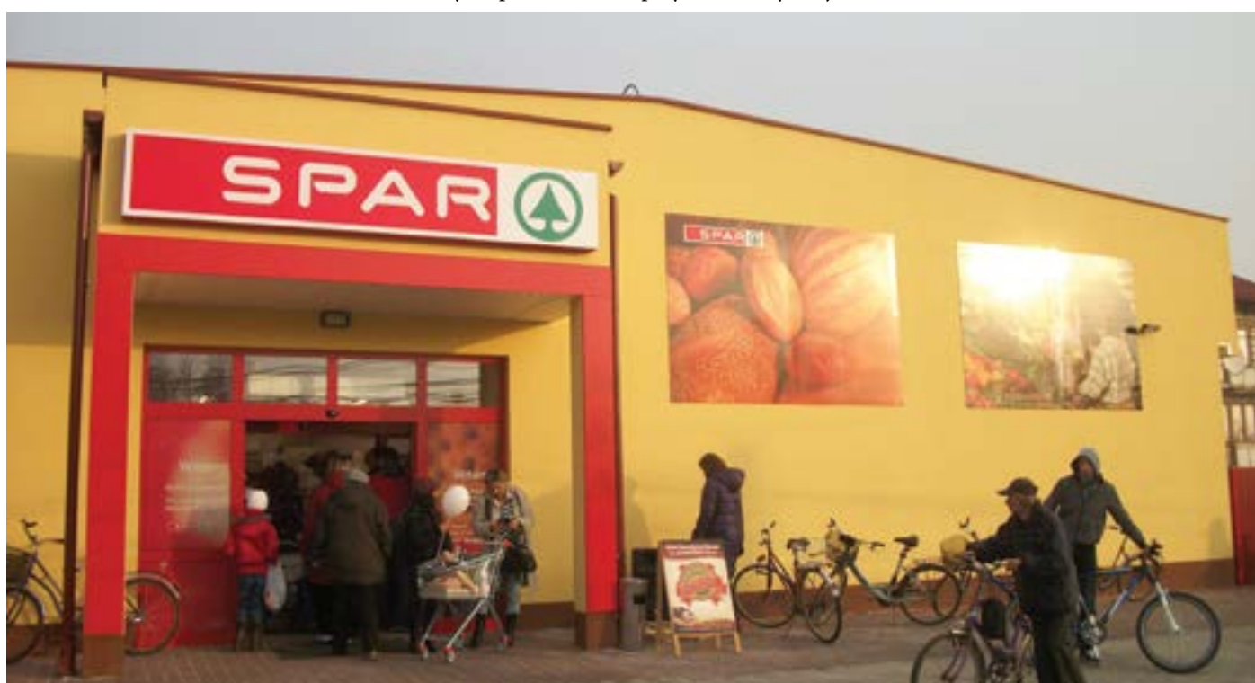
Sklep SPAR wykonany w technologii SUNDAYsystem™ - wejście główne
