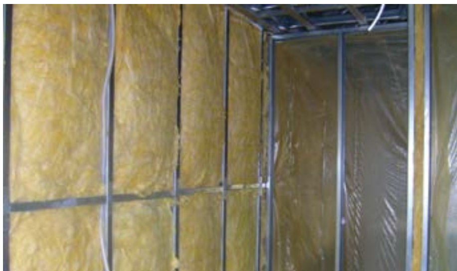
Izolacja ścian
