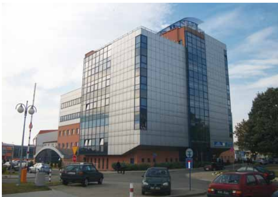
Politechnika Rzeszowska budynek P, ściany osłonowe wykonane w technologii SUNDAYsystem™
