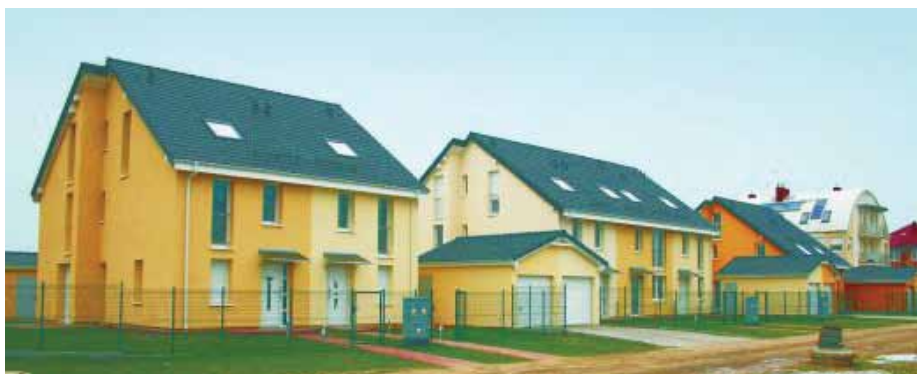
Etapy powstawania budynku pasywnego, od prawej budynek 7-litrowy, dwa budynki 3-litrowe oraz budynek pasywny - kompleks Gdańsk-Homera
