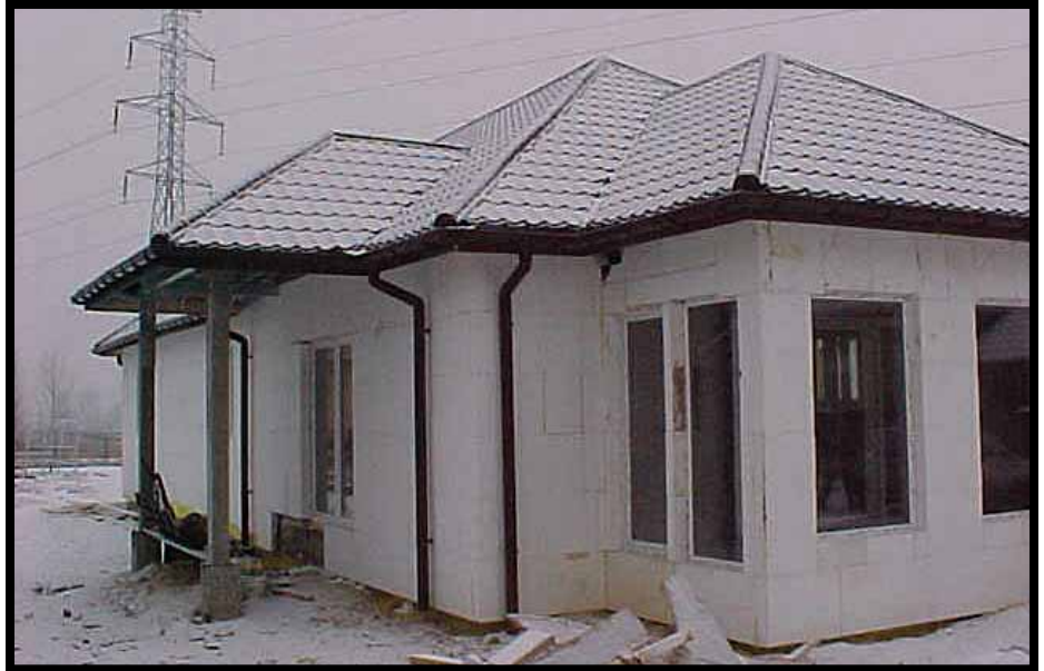
Dom w trakcie budowy
