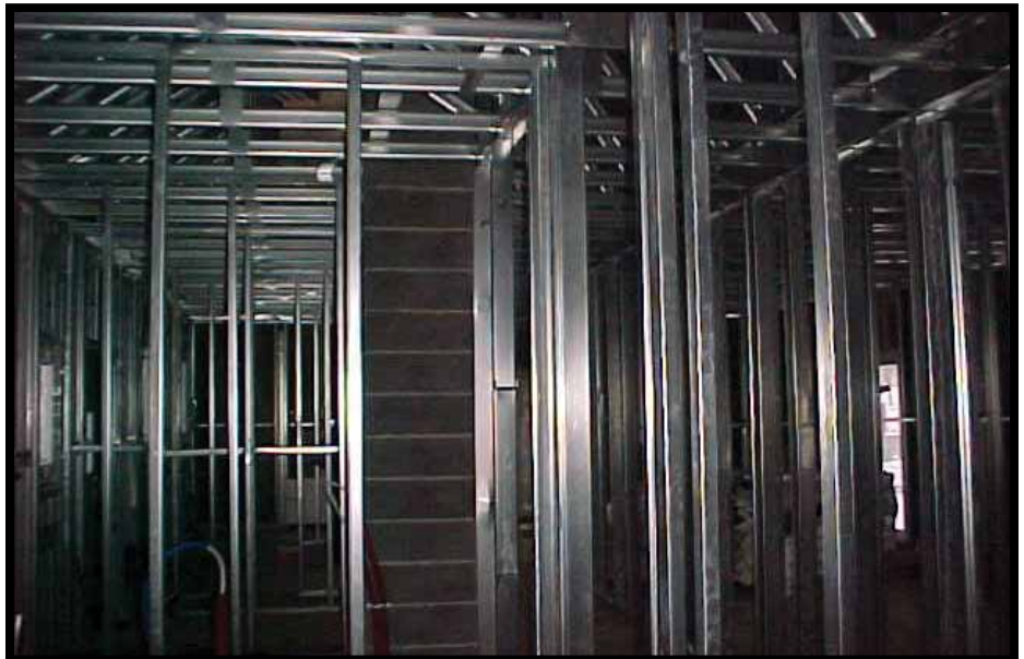
Wnętrze budowanego domu
