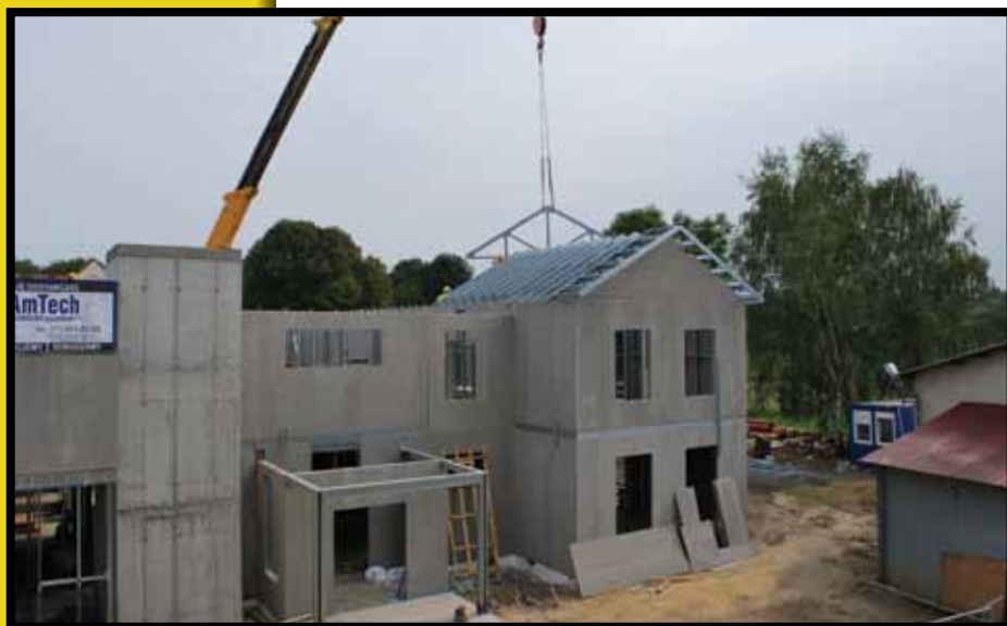
Montaż dźwigarów dachowych
