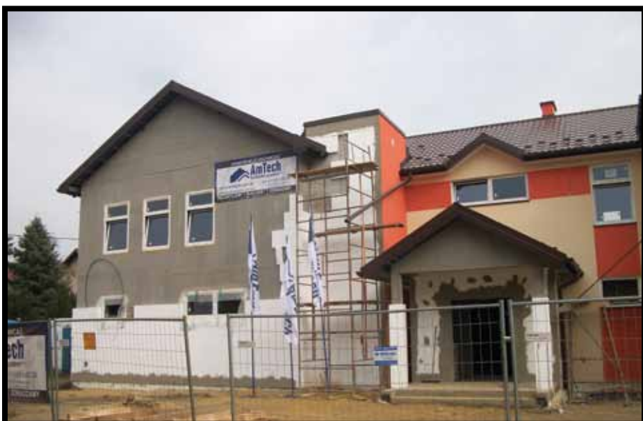
Docieplenie budynku
