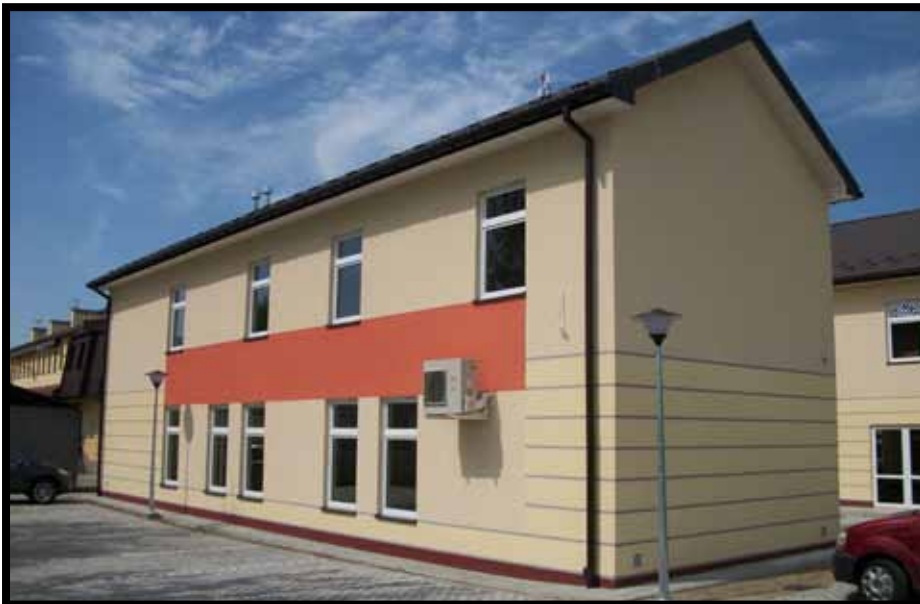
Budynek od strony wschodniej i północnej
